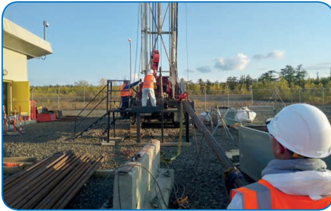
Буровые работы на водозаборе ОБТК
